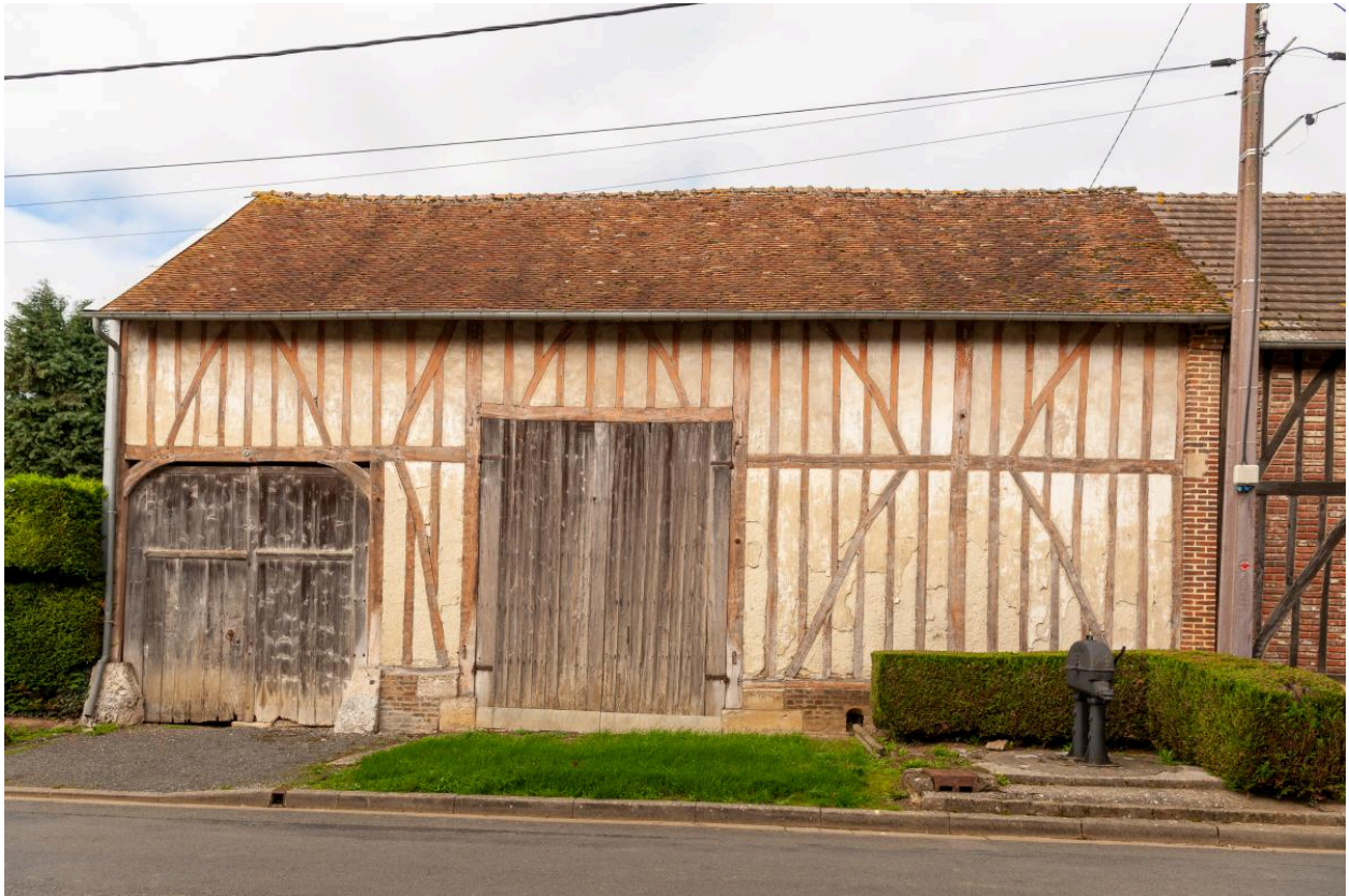
Ancienne grange avec entrée charretière, n°14 rue de la Place, vue depuis le sud-est.
