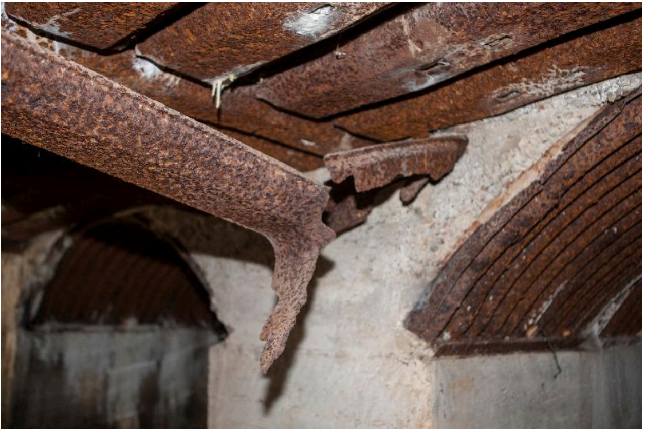
Détail de coffrage
