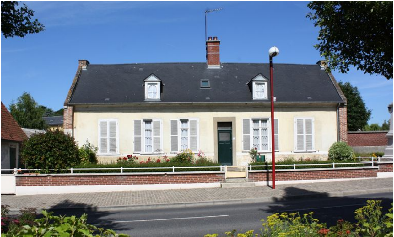
Vue générale, façade sur rue.
