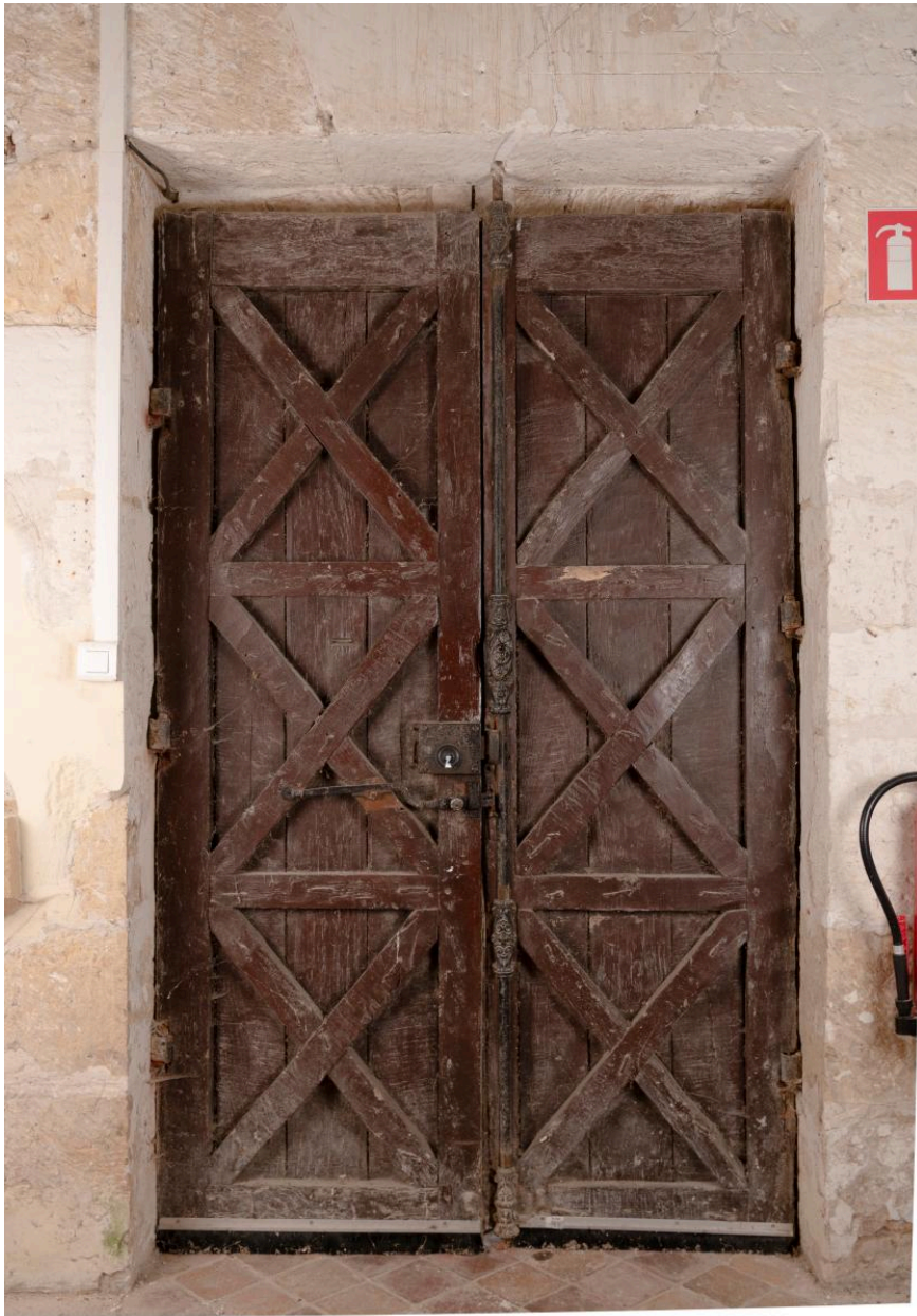
Vantaux de la porte d'entrée, vue de l'intérieur, 17 e siècle.
