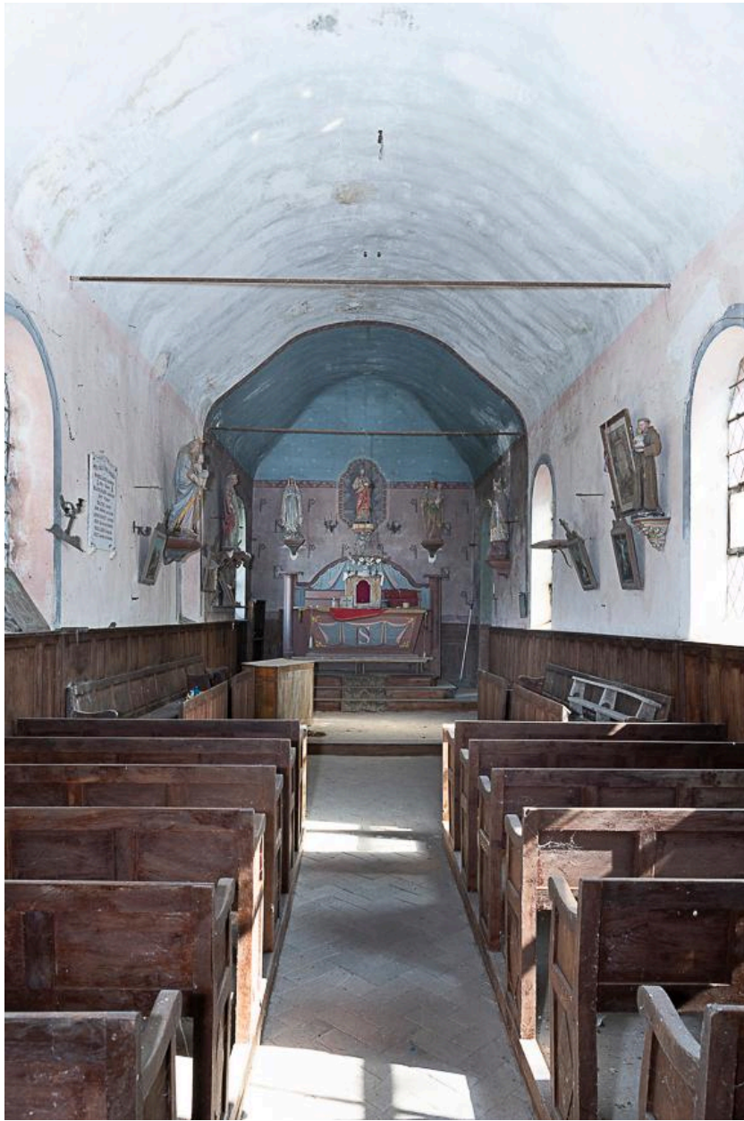
Vue générale vers le choeur.
