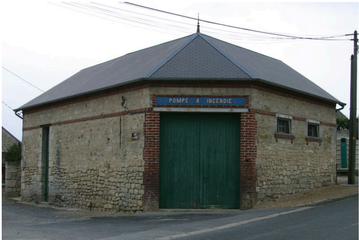
Vue de la pompe à incendie.
