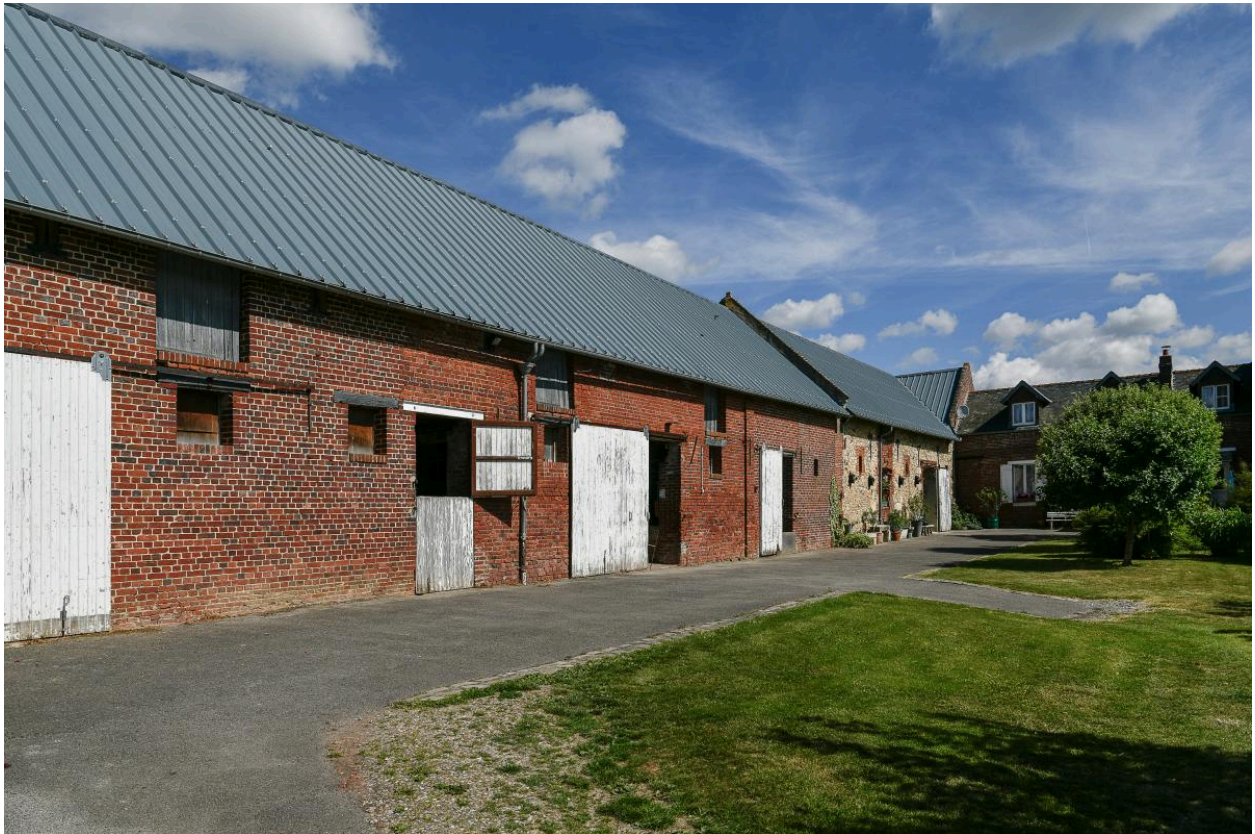
Vue générale des anciennes étables et anciennes écuries depuis le sud-est.
