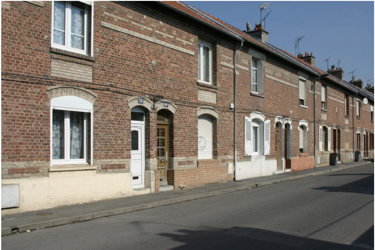
Façade antérieure des logements construits rue de Savoie en 1922, face à la cité Dambrun.
