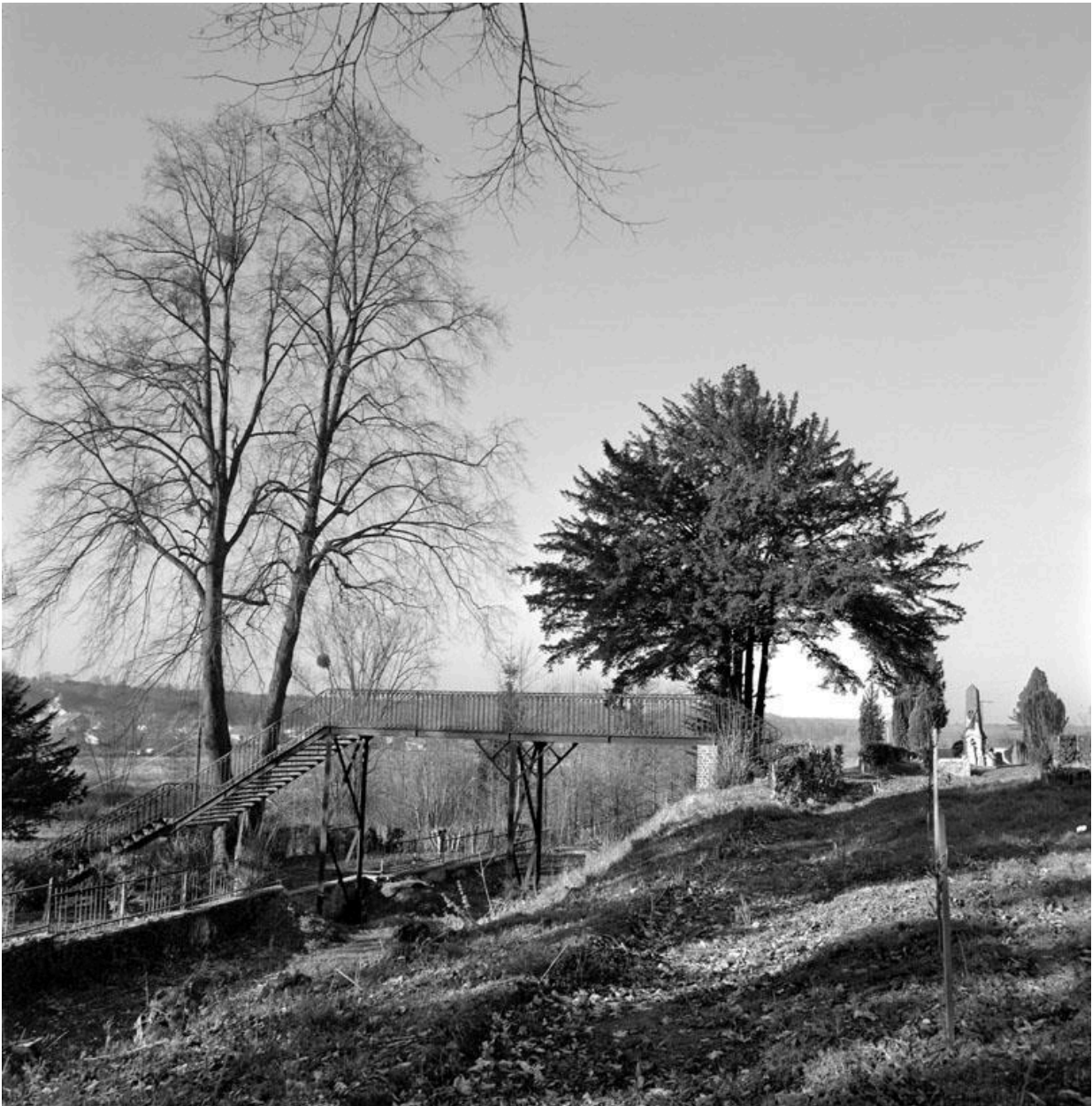
Vue de la passerelle reliant les 2 parties du jardin, et sous laquelle passait la voie ferrée.
