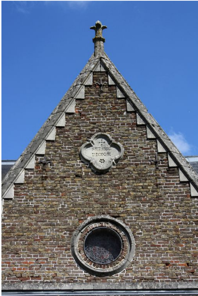
Pignon du transept nord-ouest.
