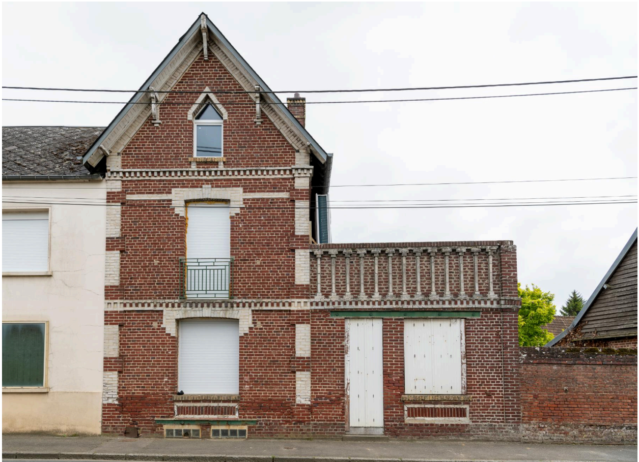
Ancienne maison du notaire Dedreux, n°45 rue de Beauvais, vue prise depuis l'ouest.
