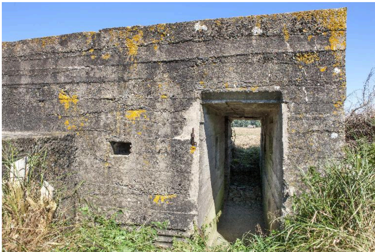
Vue en enfilade du couloir de distribution, vers le nord-ouest
