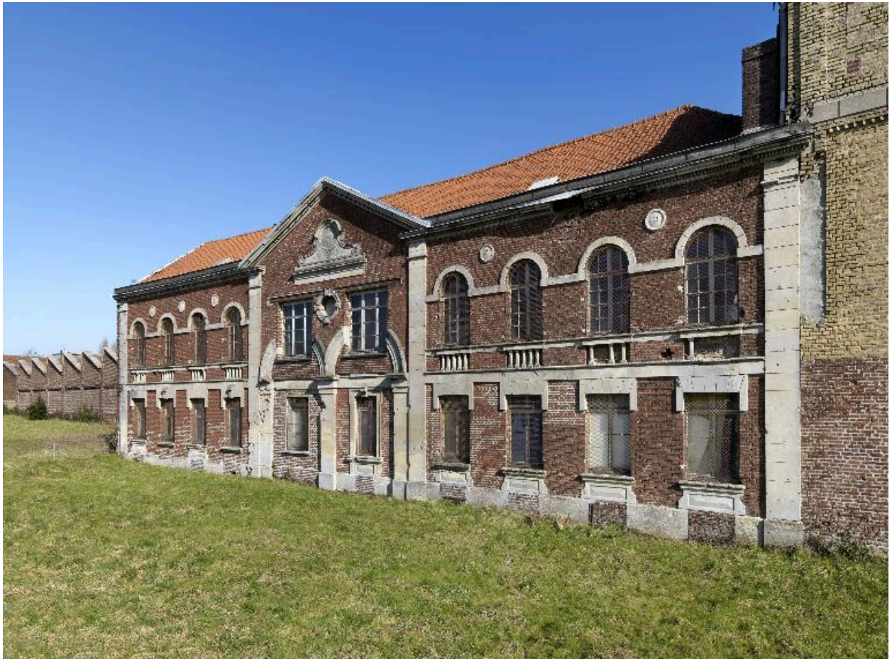
Façade ouest de l'atelier de pliage.
