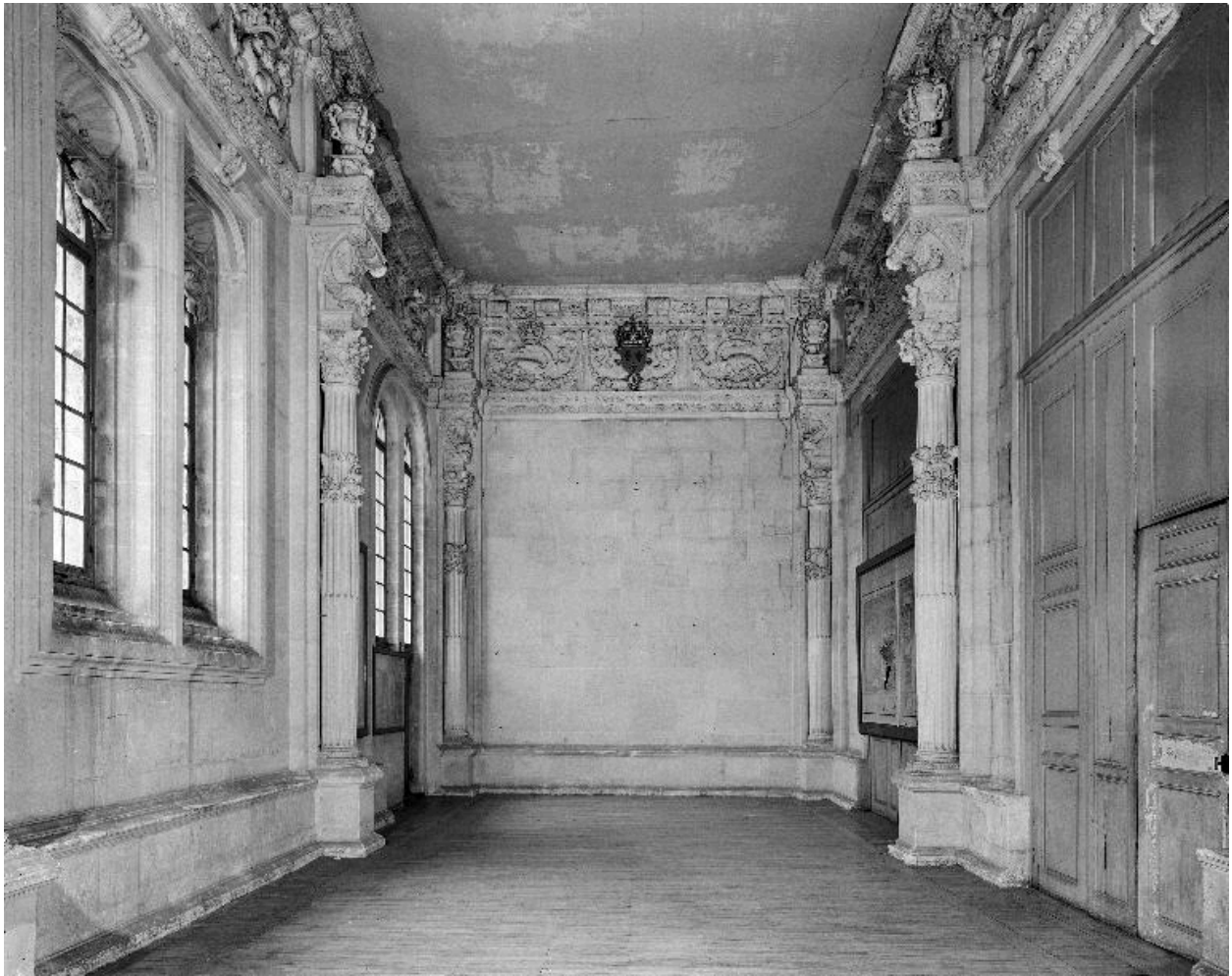
Vue intérieure de la chapelle, prise d'est en ouest.
