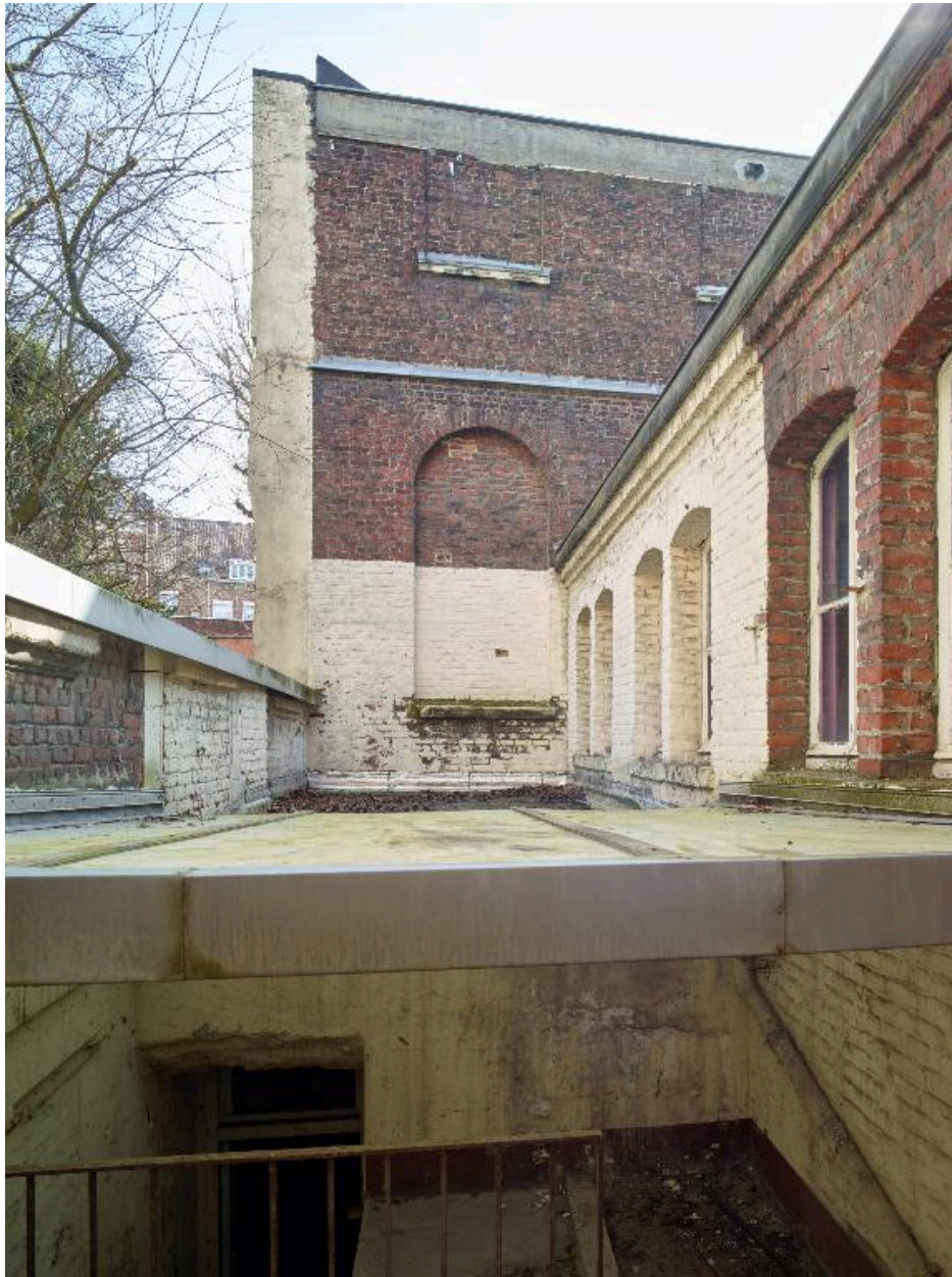
Vue depuis la cour nord vers le bâtiment du dépôt (au fond) et la salle de triage (à droite).
