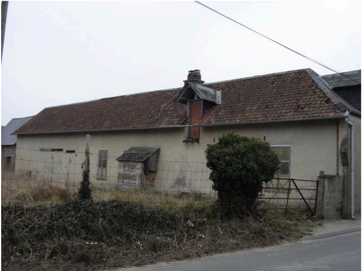
Vue postérieure du logis et du four à pain.
