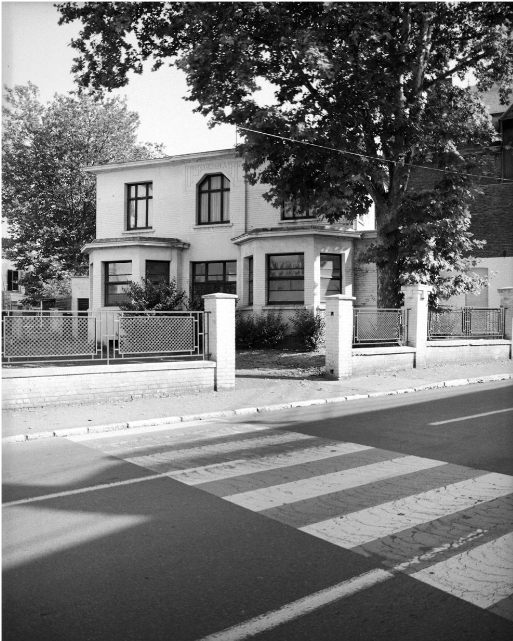
Vue générale du dispensaire.
