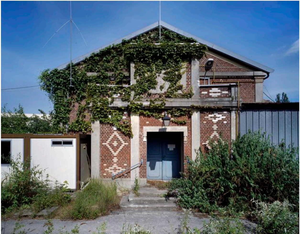
Façade principale de la salle des fêtes.
