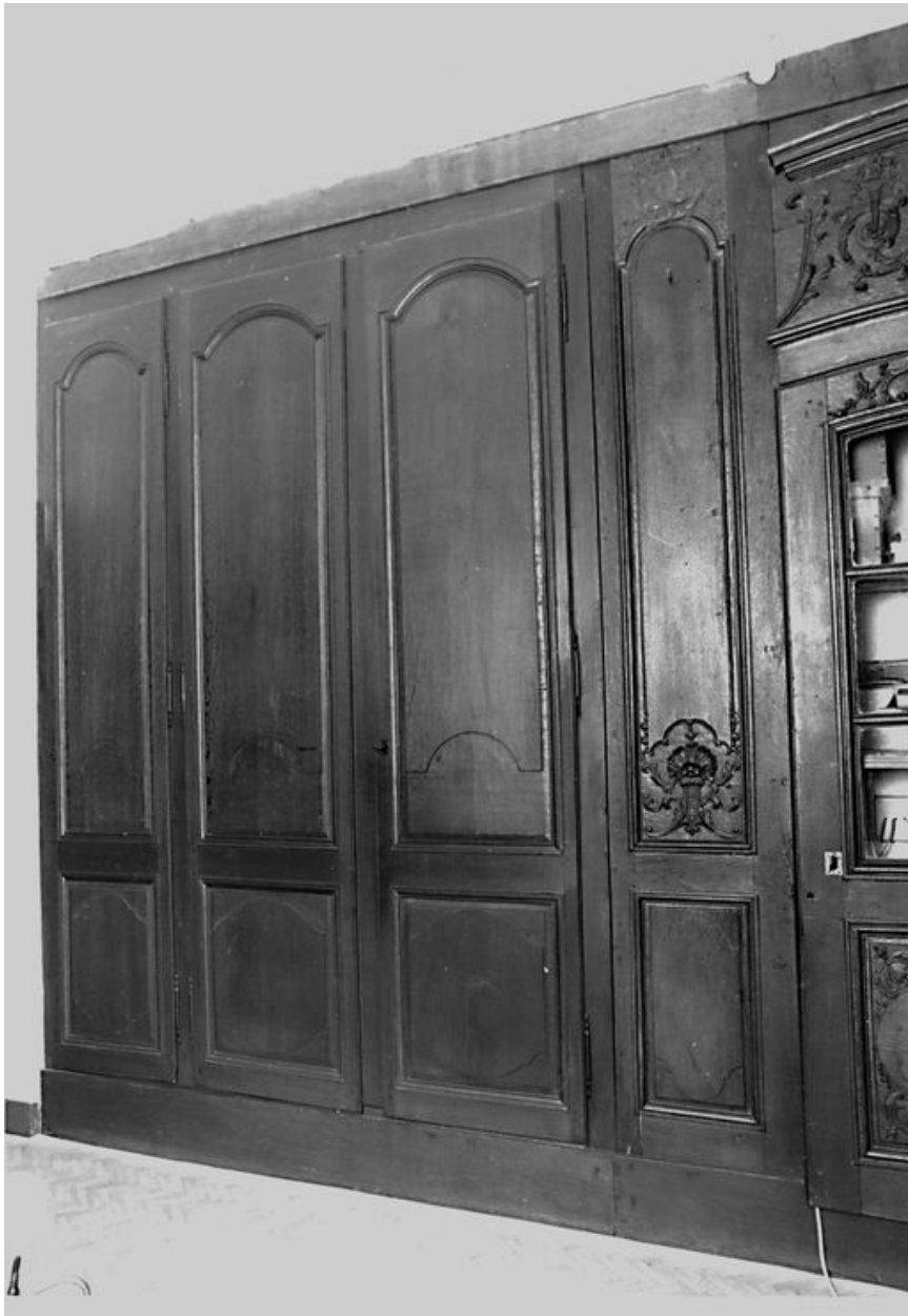
Sacristie : partie gauche des lambris de revêtement.
