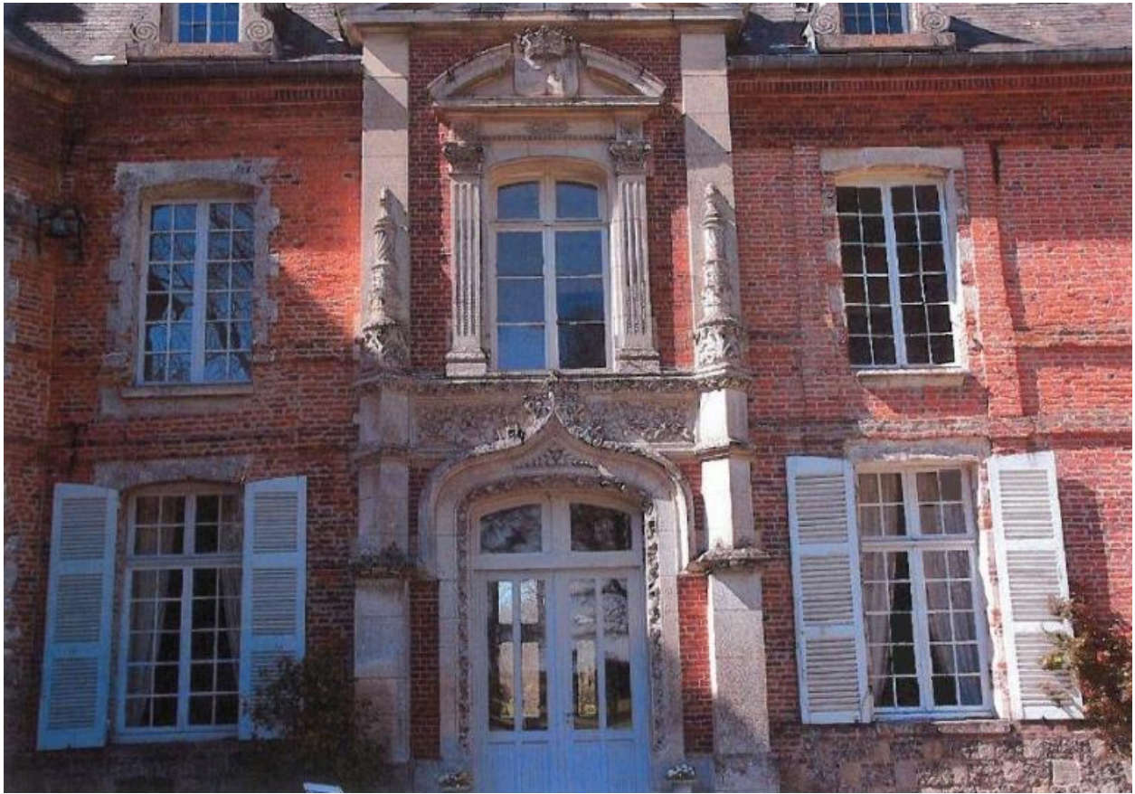
Travée centrale de la façade postérieure.
