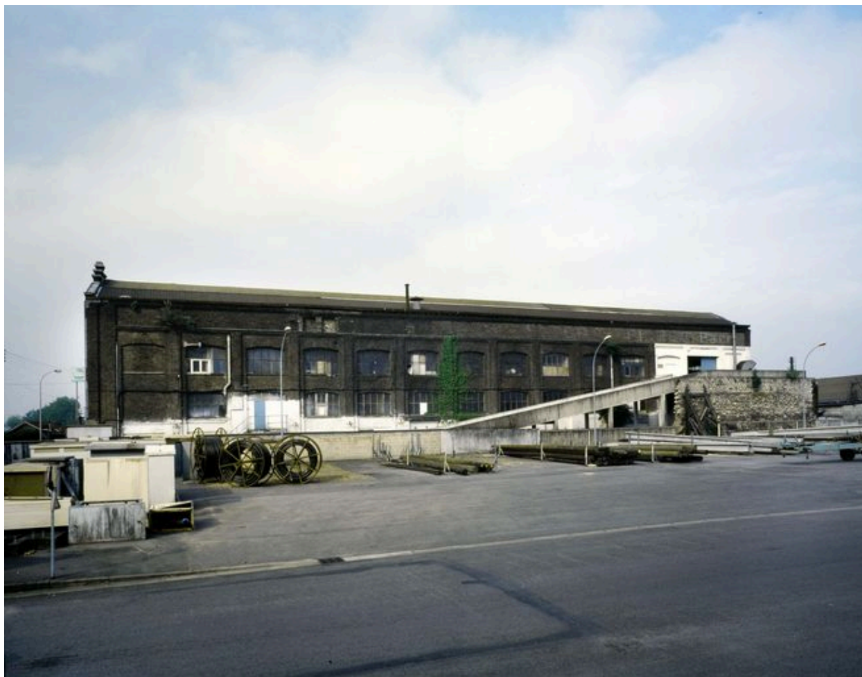
Façade est de l'usine Fichet.
