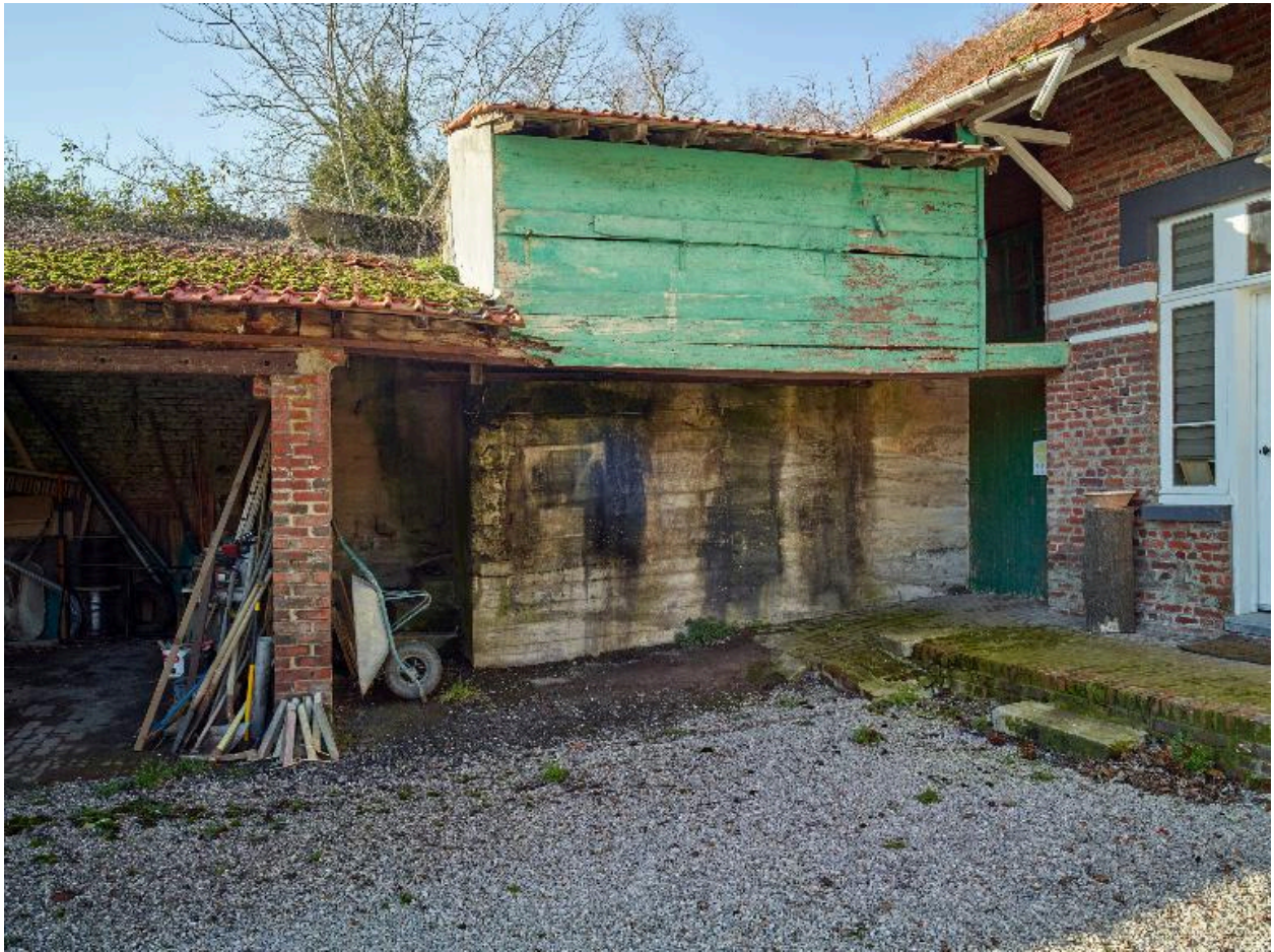
Partie nord de la casemate, depuis la cour de la ferme.
