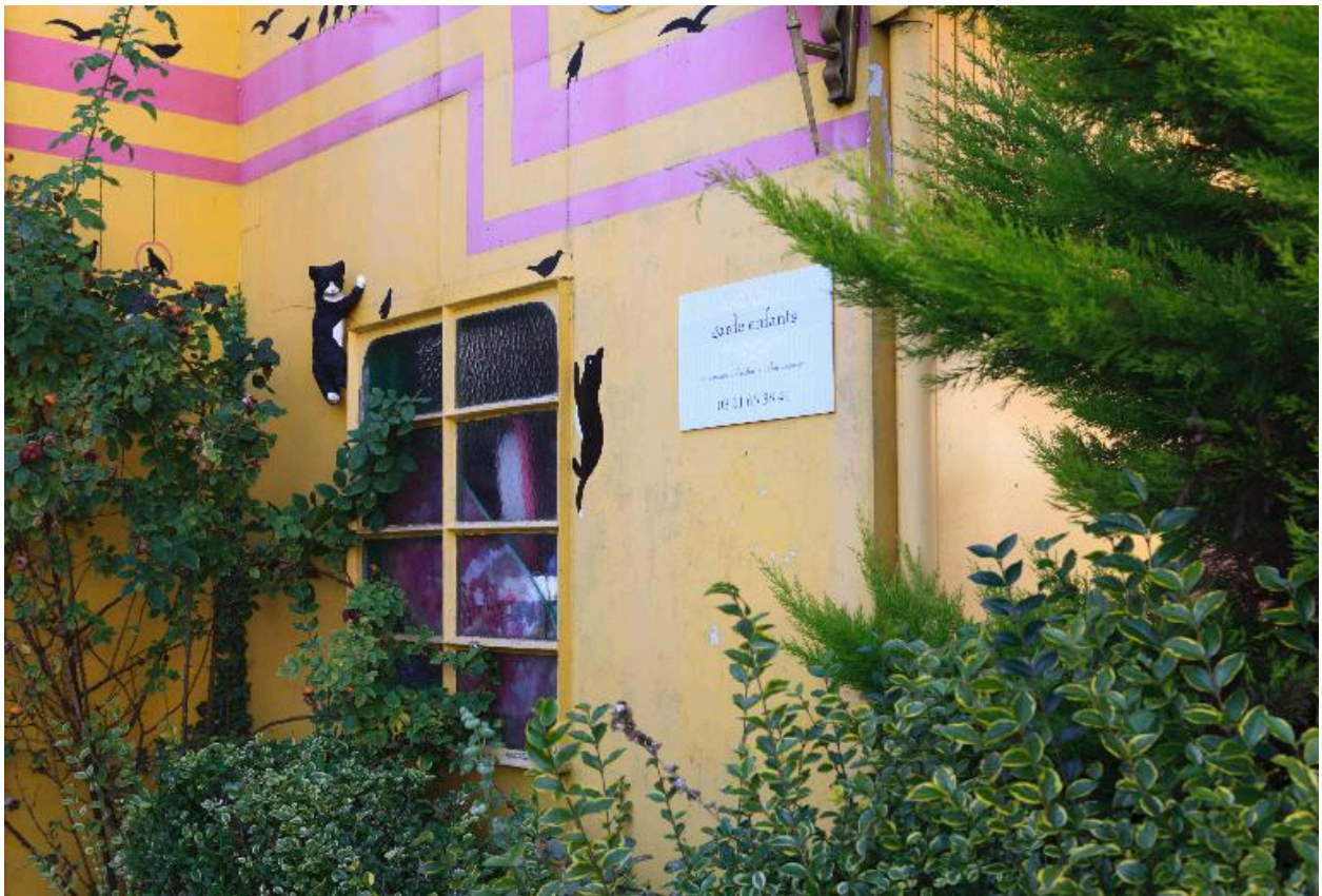
Façade antérieure, vue partielle.
