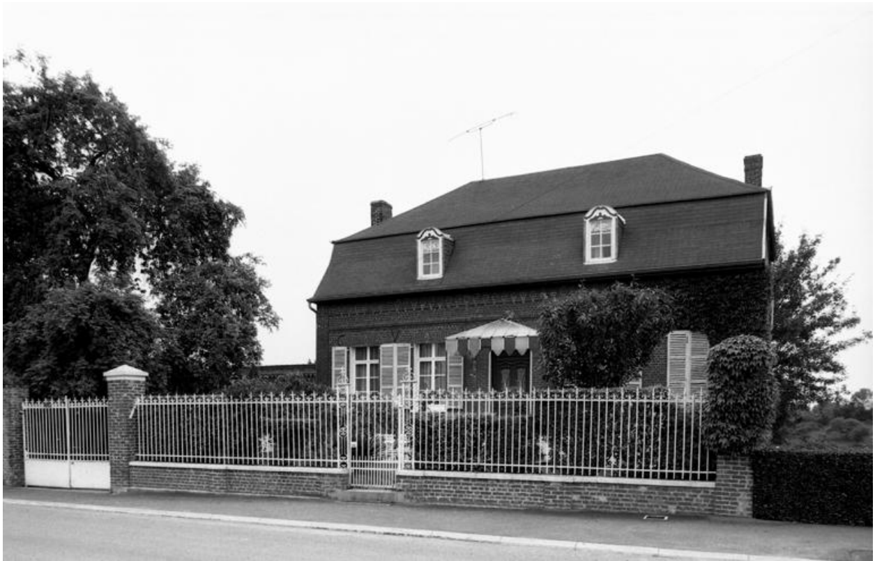
Vue de la façade du logis.
