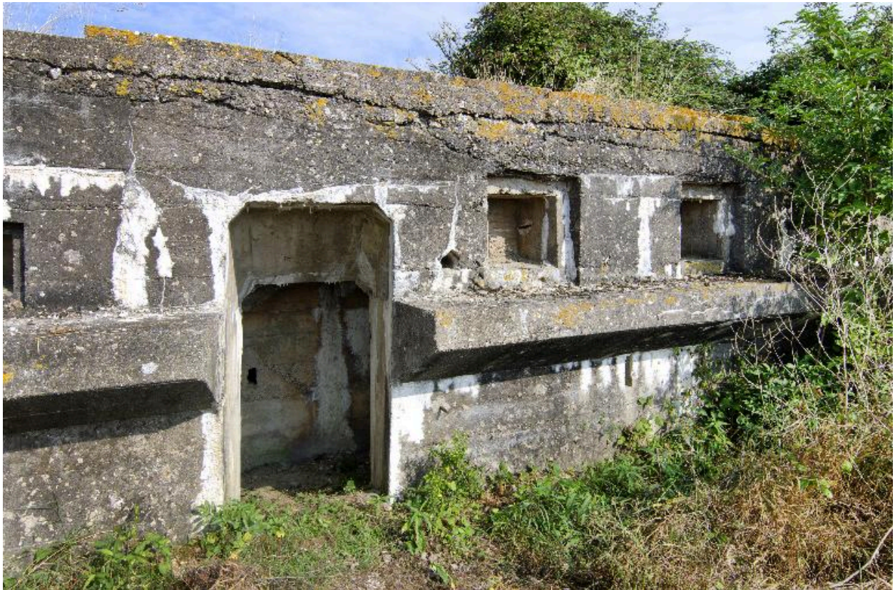
Partie est de l'édifice. Entrée et banquette de tir
