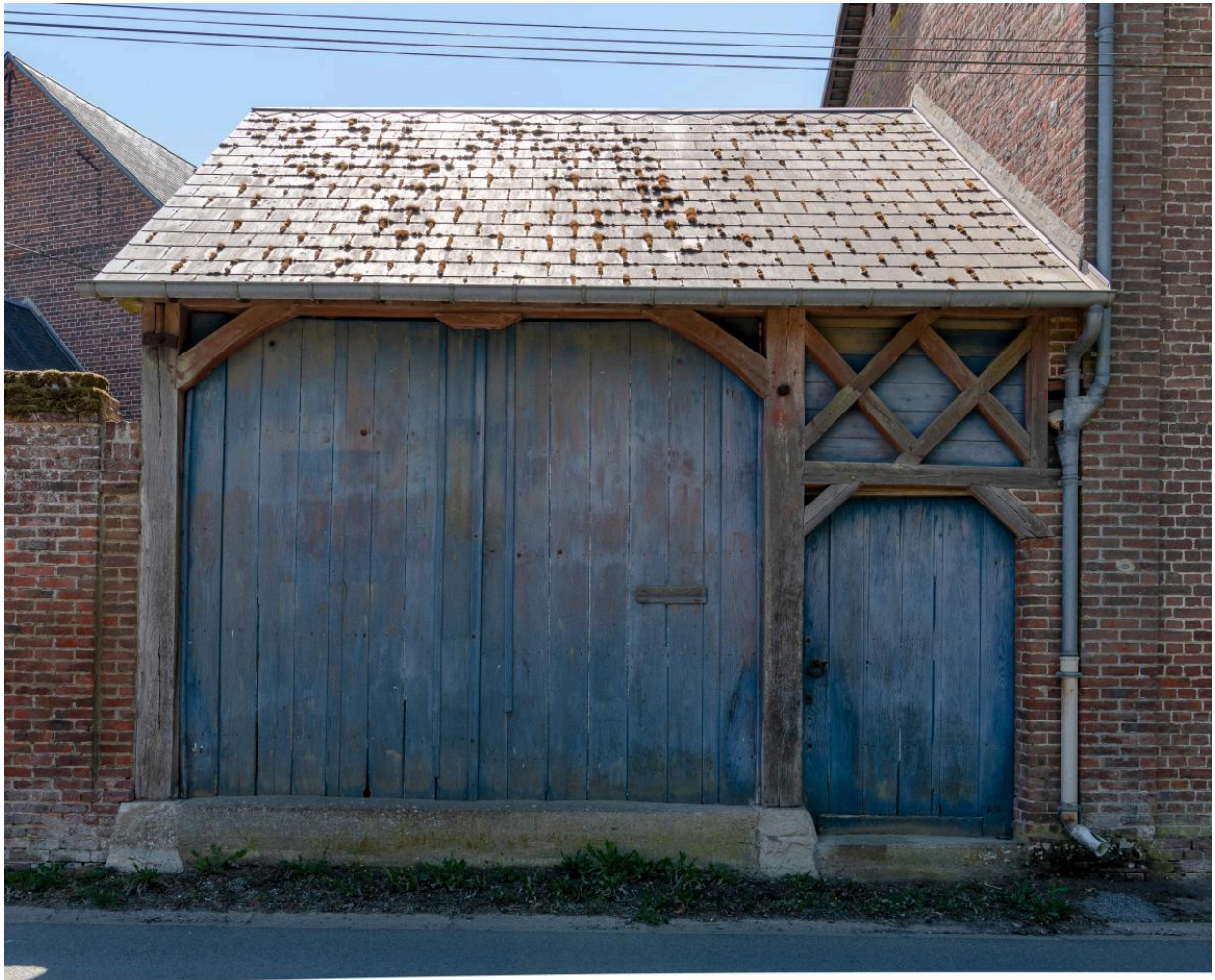
Porte charretière et porte piétonne avec imposte ajourée, n°14 Grande Rue, vue depuis le nord.
