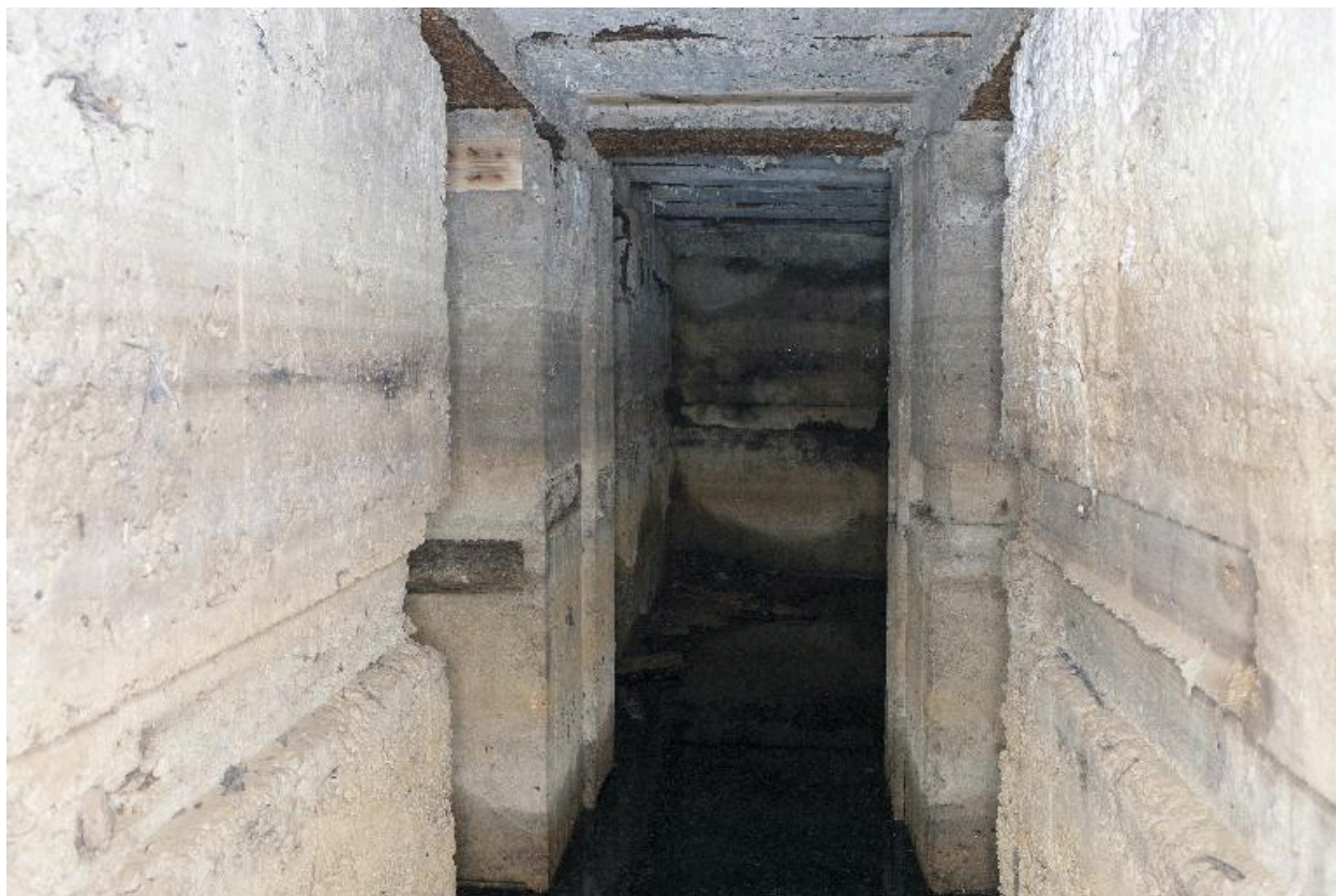
Couloir C2 vers la salle S4
