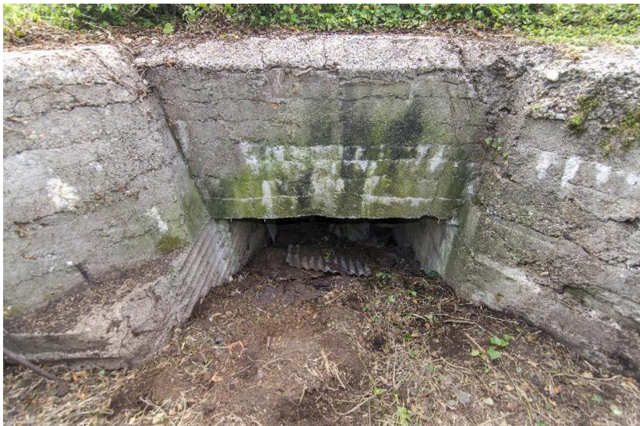
Elévation nord, la cuve à canon (au grand angle)
