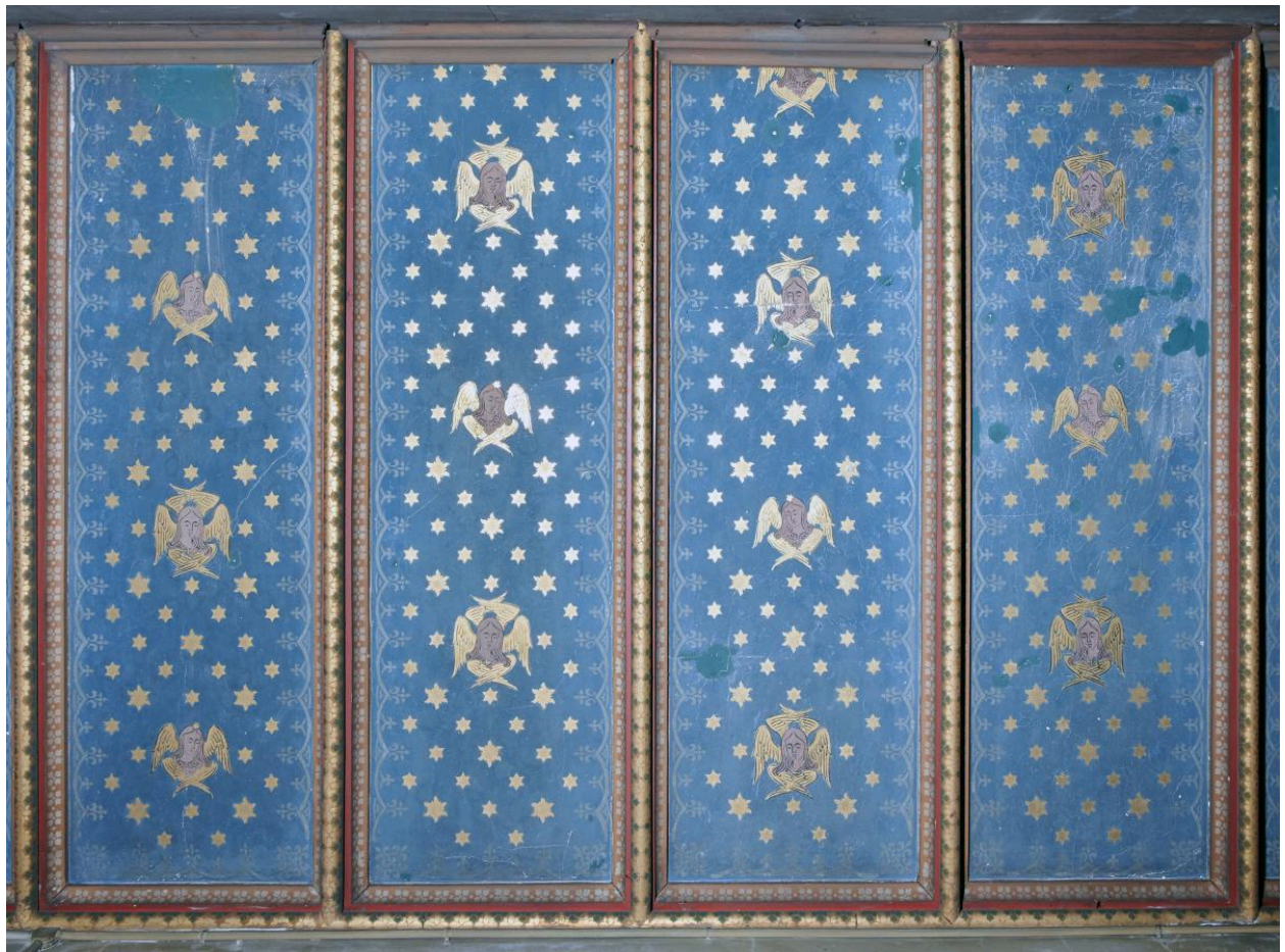
Vue générale du lambris de couverture sous la tribune de l'orgue.
