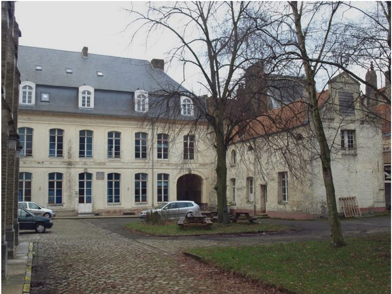
Façade arrière, et bâtiment annexe en retour d'angle
