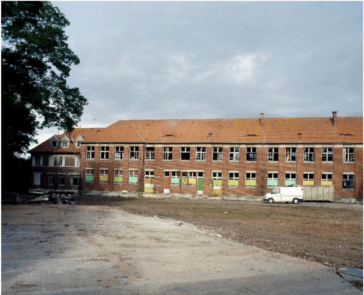
Façade postérieure, avenue Danicourt.
