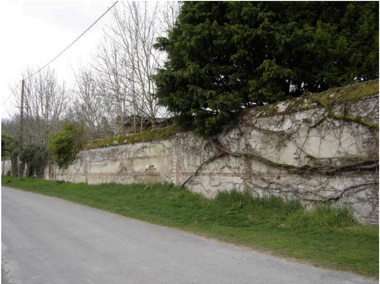
Vue du mur extérieur.
