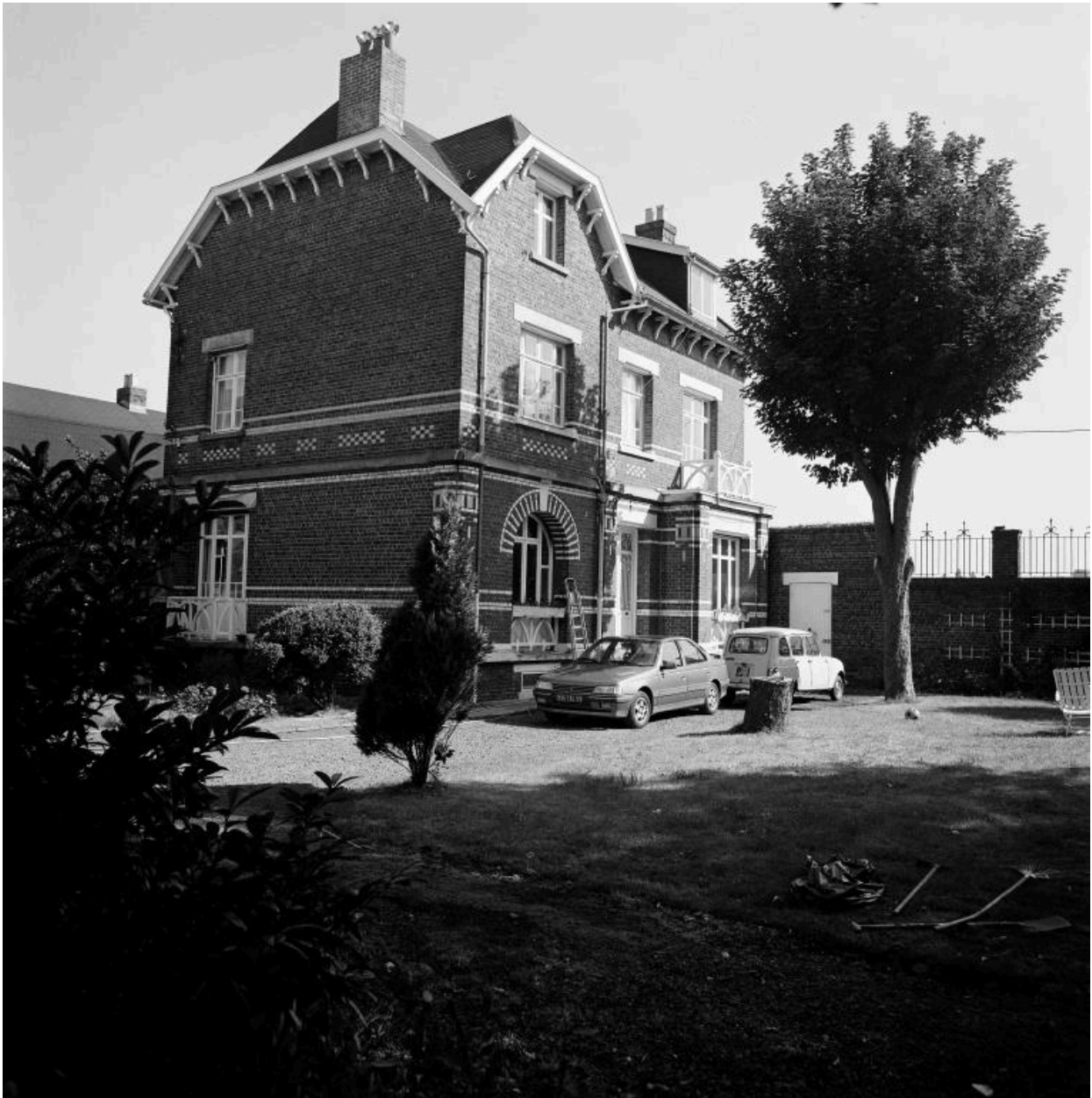
Logement patronal. Vue prise vers le nord.
