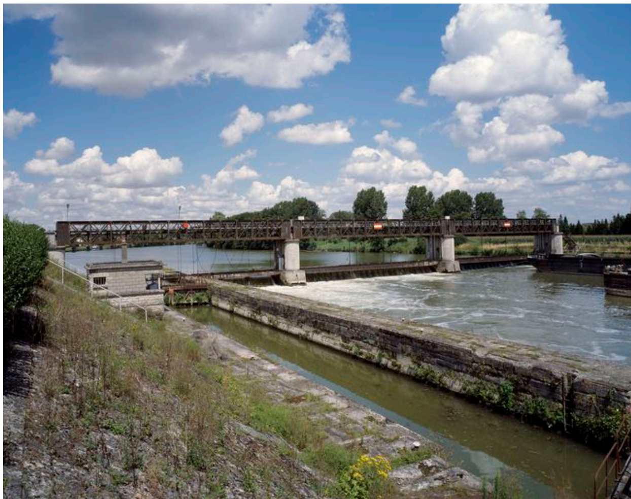
Sarron : vue générale du barrage Derôme construit en 1891 et de l'écluse (désaffectée).
