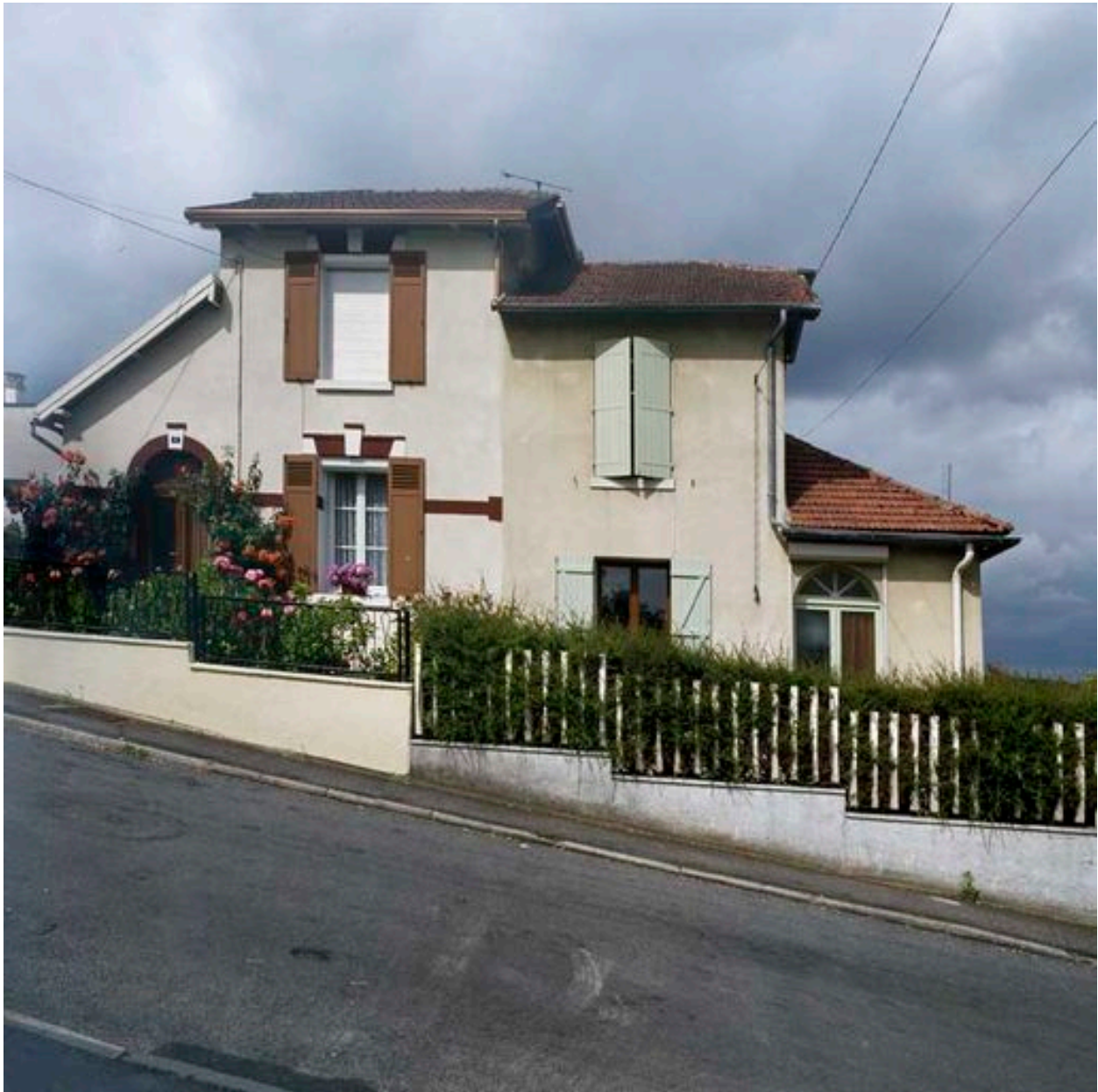
Logements jumelés de la cité Mimbertain.
