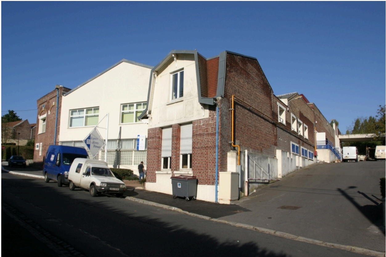
Vue générale de l'usine.
