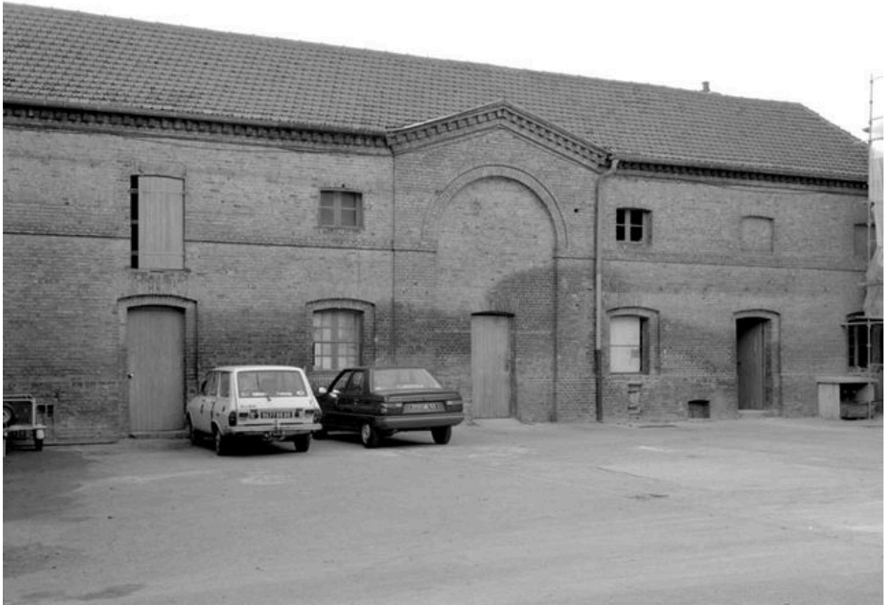
La ferme, façade ouest sur la cour, en 1983. Aniennes grange, étable et laiterie du monastère.
