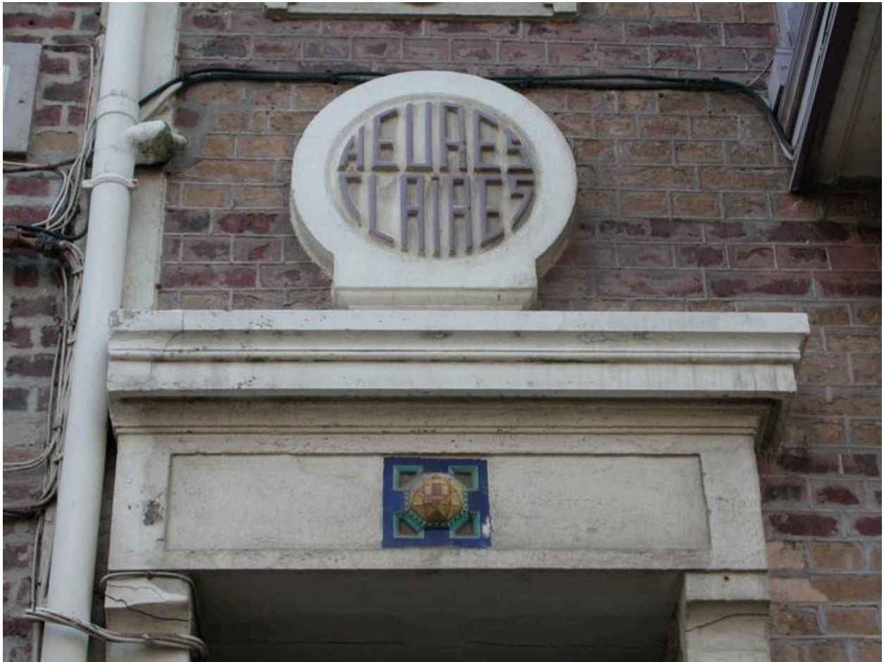
Détail de l'entrée du logement de gauche, Heures Claires.
