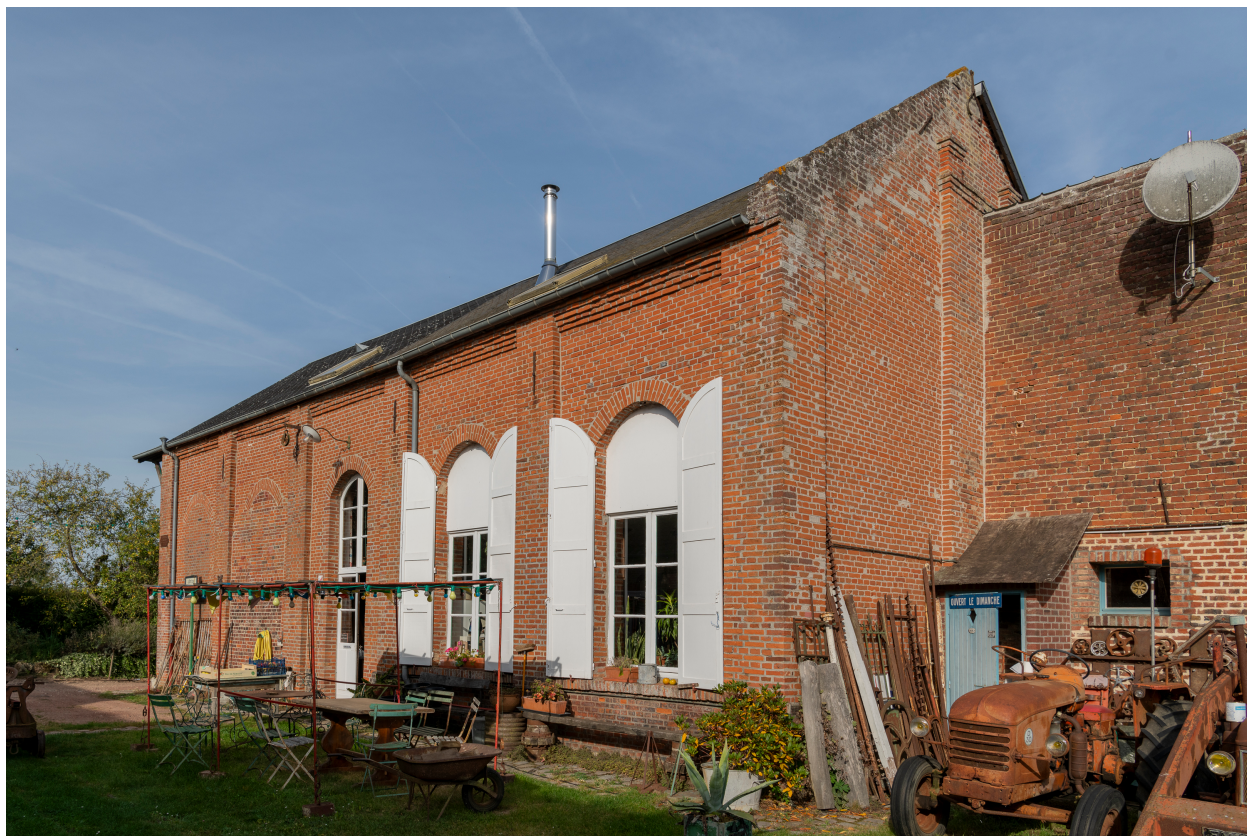
Ancien atelier, vue depuis le sud-est.
