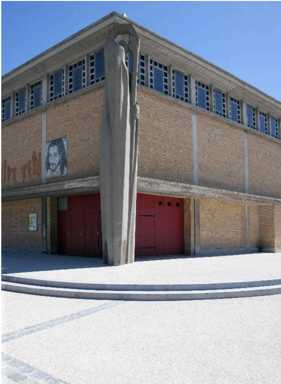
Entrée de l'église sur les flancs sud et ouest.
