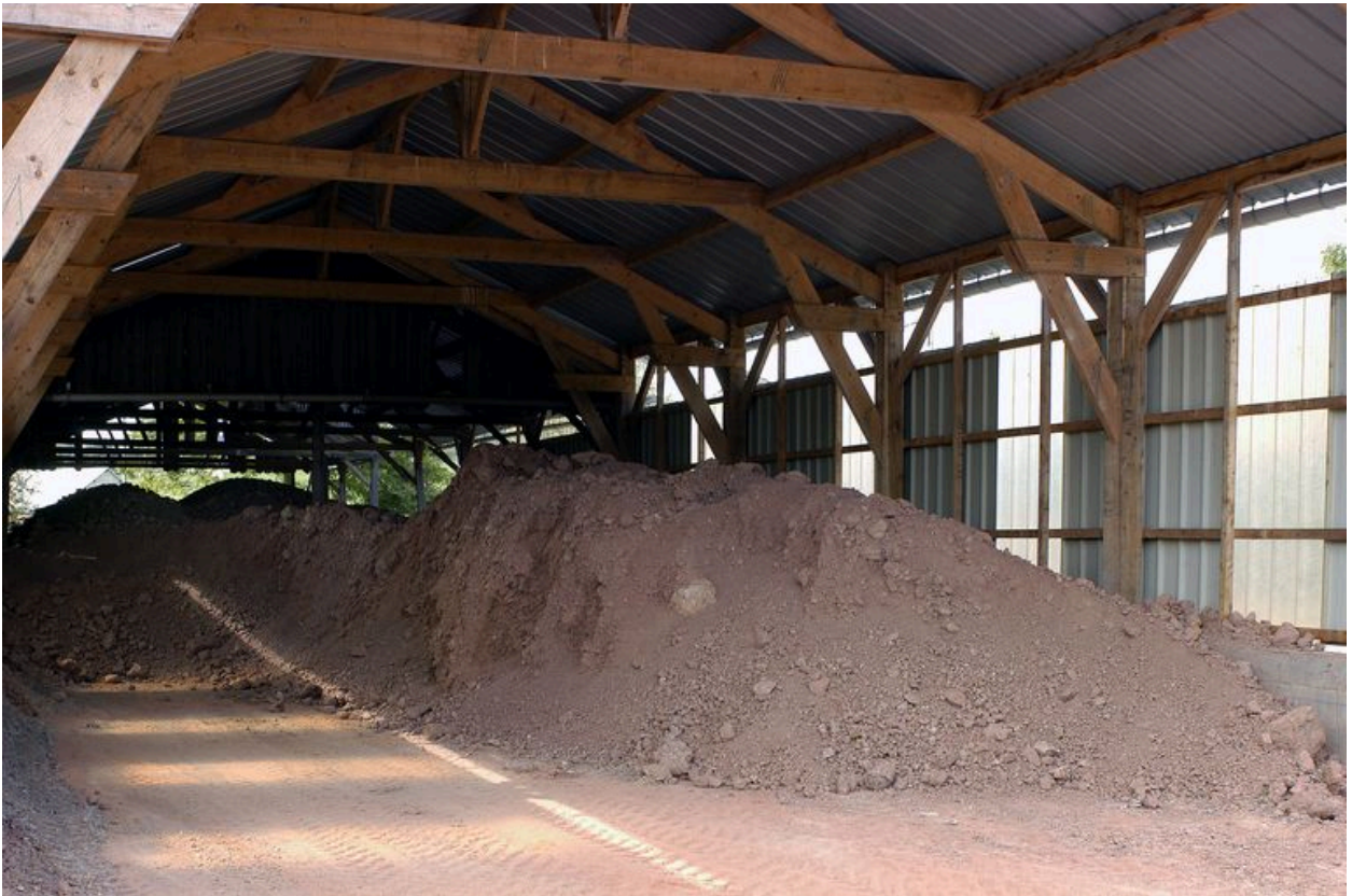
Hangar d'entrepôt à terres.
