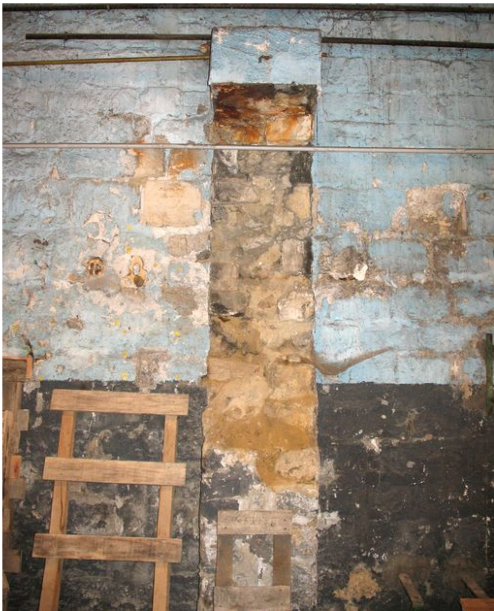
Appareillage des pierres.
