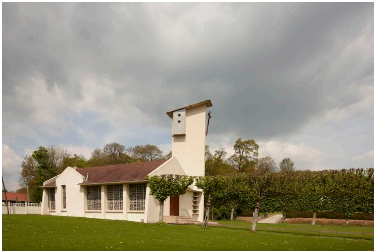
Vue générale latérale.
