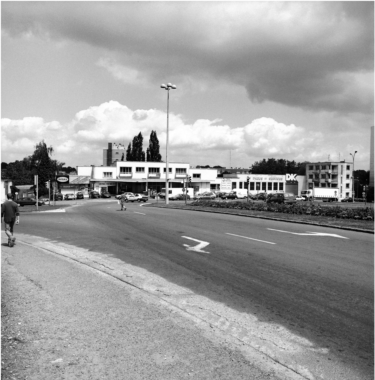
Vue générale du garage, de l'atelier et de l'immeuble à logements.
