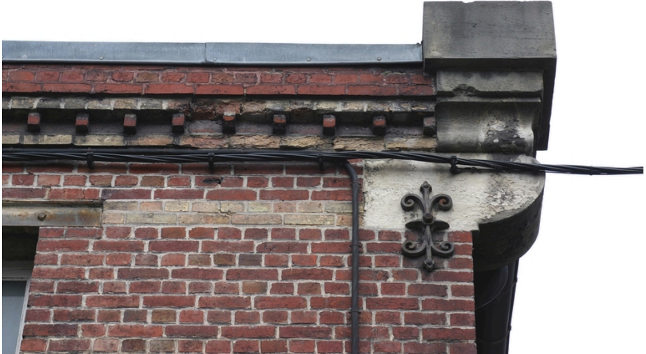
Façade antérieure des ateliers : détail.
