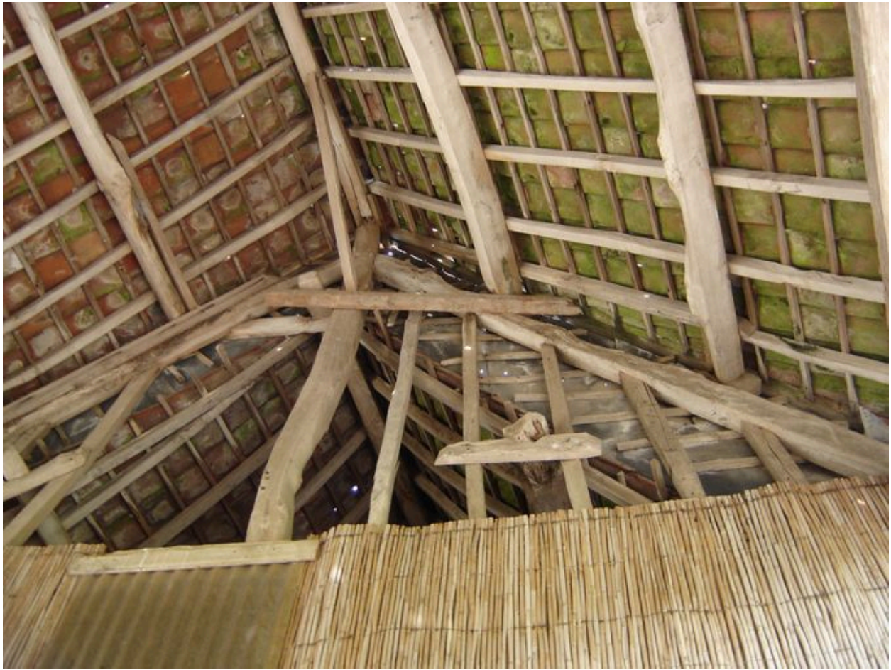
Vue de la charpente du passage couvert.
