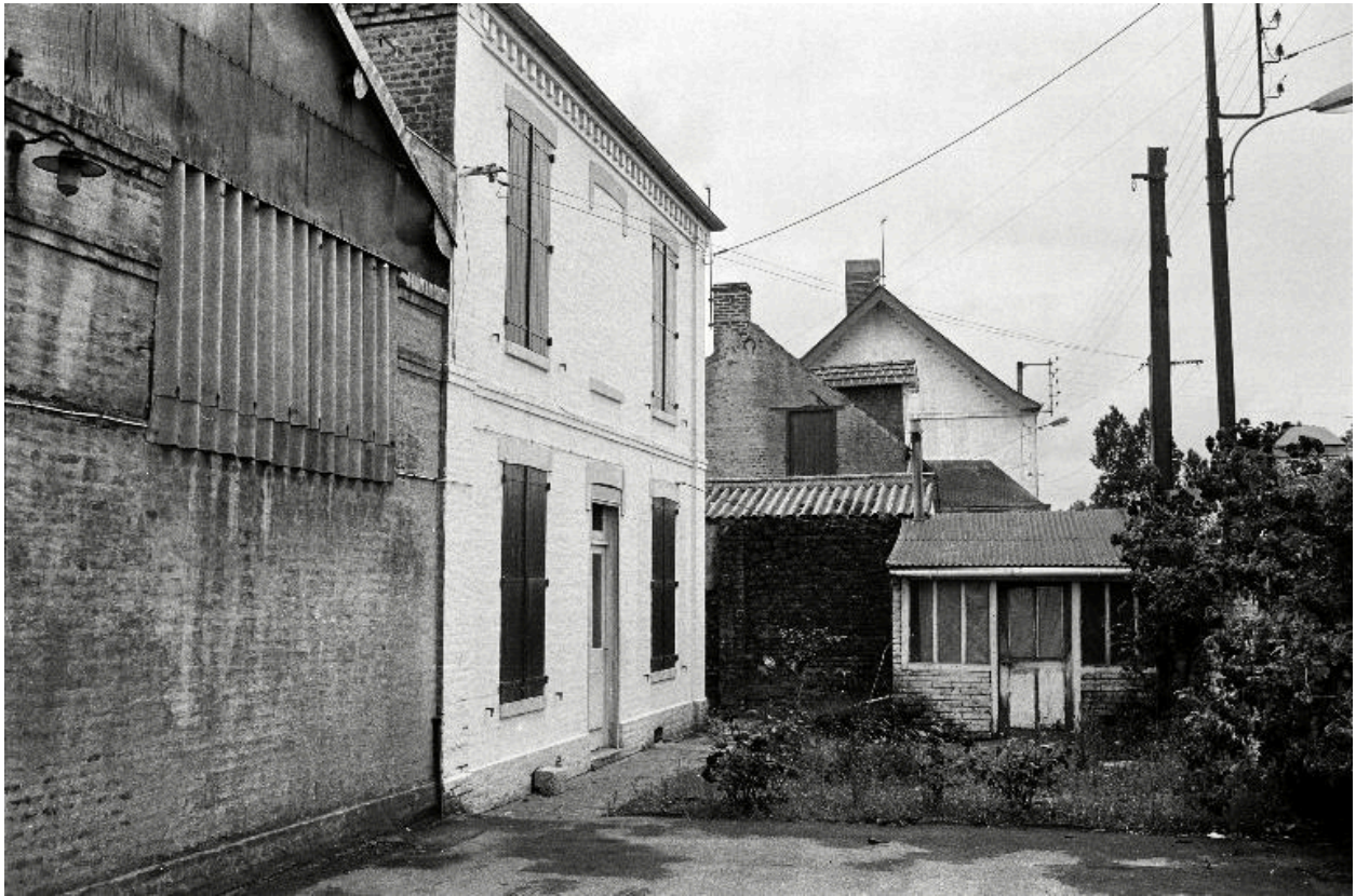
Logement patronal, vue partielle, en 1990.
