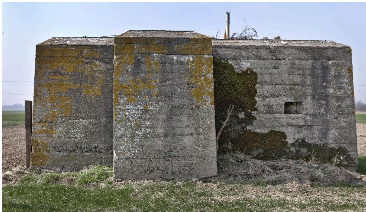
Vue vers l'ouest. Au premier plan le porche pare-souffle
