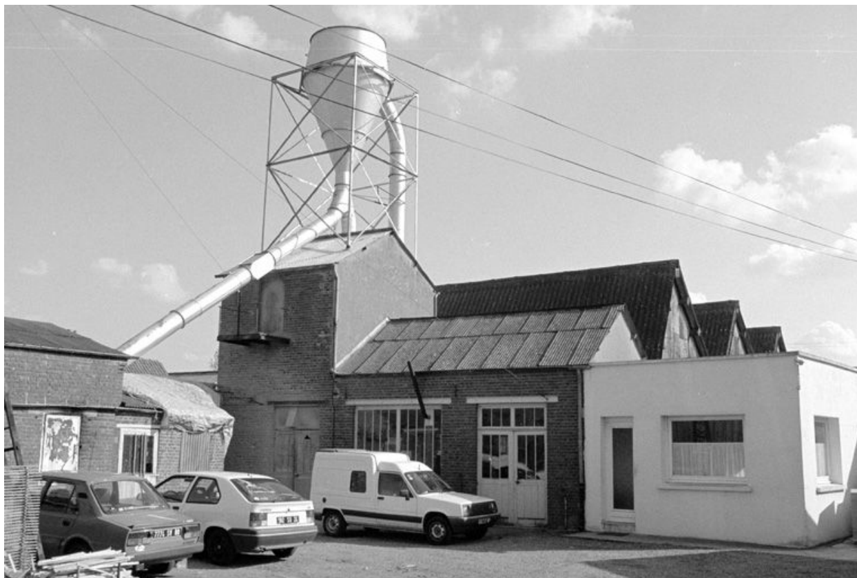
Vue générale de l'usine, en 1990.
