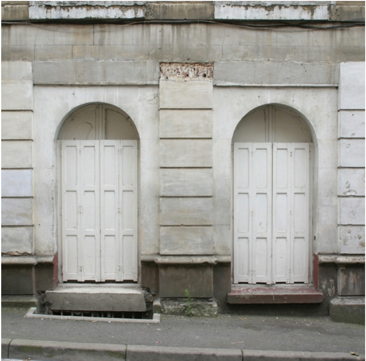
Baies du rez-de-chaussée.
